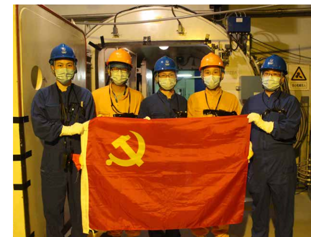
福清核电大修现场“维修铁军”党员突击队
