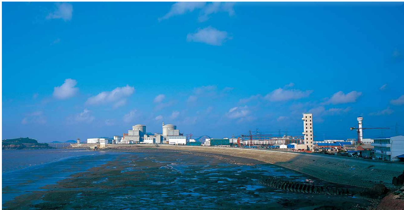
秦山二期 1、2 号机组外景
